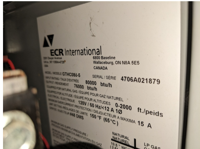
Furnace by Olsen; Model: GTHC080-5; 80 kBTU/h; 95% AFUE
